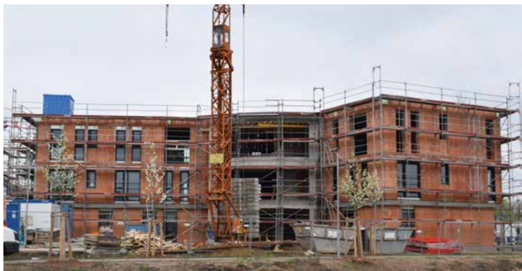
Der Rohbau steht: In Linkenheim-Hochstetten wurde Richtfest gefeiert.
