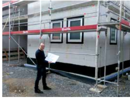
Es geht voran: Projektleiter Florian Weber vor dem Neubau in Bad Mergentheim.
