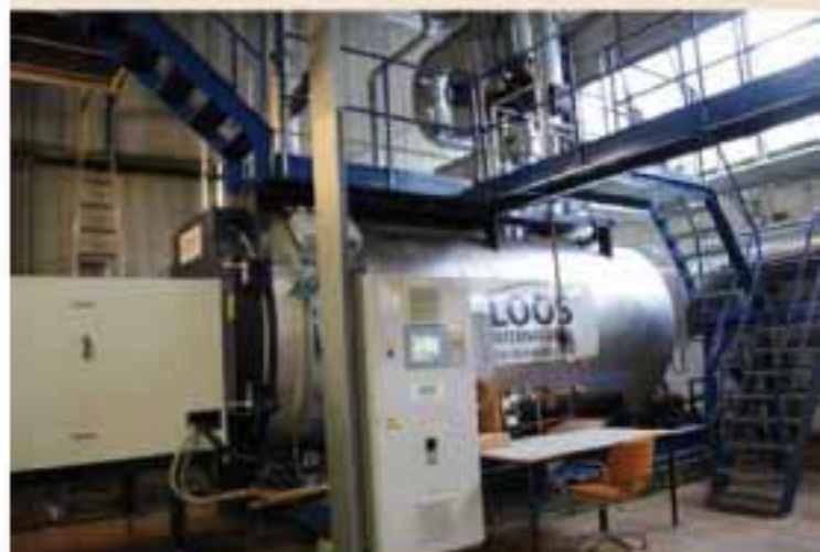
Hier wird das warme Wasser erzeugt.
