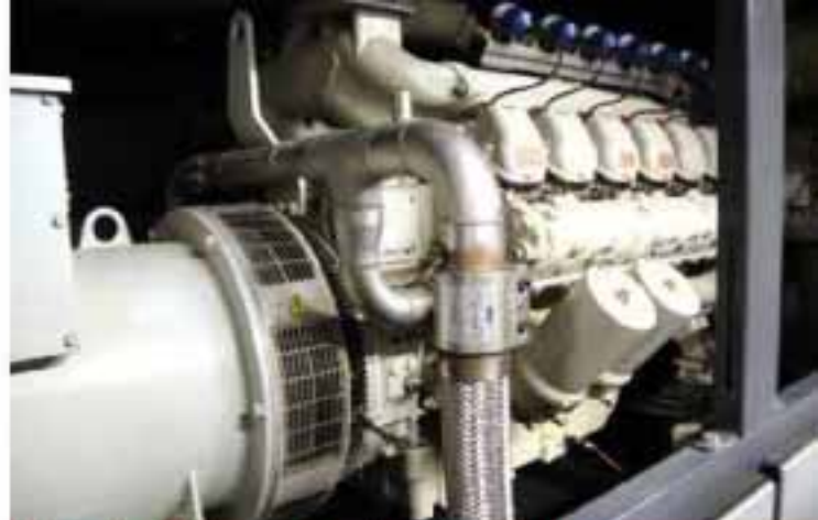
Links der Generator, rechts der Gasmotor
